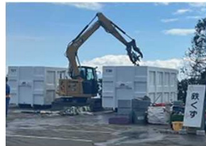
災害ごみ仮置場
