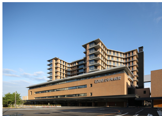
石川県 「新県立中央病院整備事業」 （平成24年度～31年度 病院事業債）
