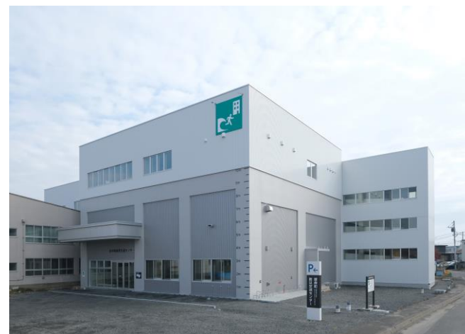
厚岸町防災交流センター (厚岸町)
