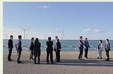
合同会社グリーンパワー石狩 石狩湾新港洋上風力発電所
