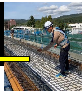
スマートフォン、タブレットをかざすだけで配筋検査における検査項目の3次元実測値を算出
