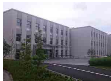
西ヶ原研修合同庁舎 (東京都北区)
