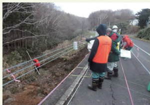
災害査定立会の現場（被災直後）
