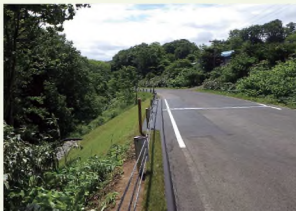
災害査定立会の現場（復旧後）
