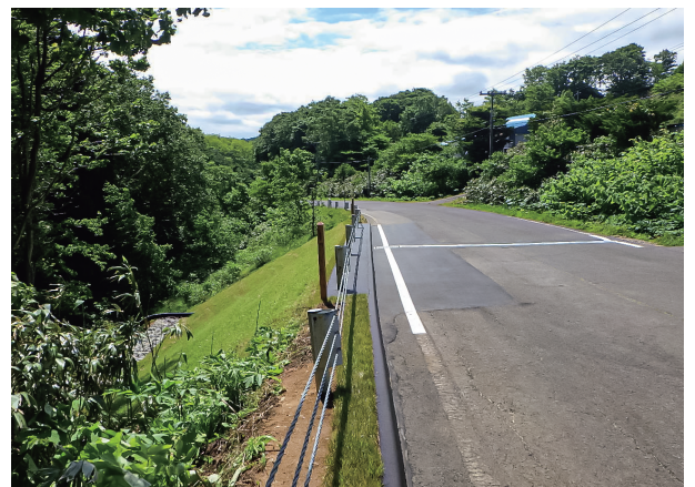
災害査定立会の現場（復旧後）
