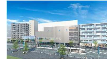
(提供)総曲輪西地区市街地再開発組合 総曲輪西地区再開発ビル(ホテル、シネコンなど) (28年5月頃完成予定)
