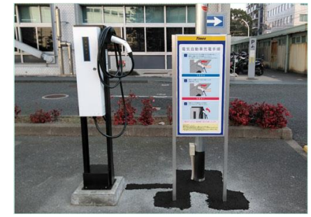
EV用充電器 / 福岡地方合同庁舎 (写真提供元：タイムズ24株式会社)
