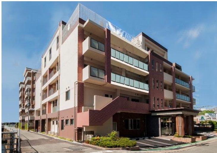
公務員宿舎跡地に整備された介護施設 (福岡市)
