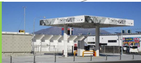
地元企業による水素ステーション整備の促進(かごしま水素ステーション(南国殖産(株)))
