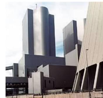
発電所 Gas Cleaning Power Plants
