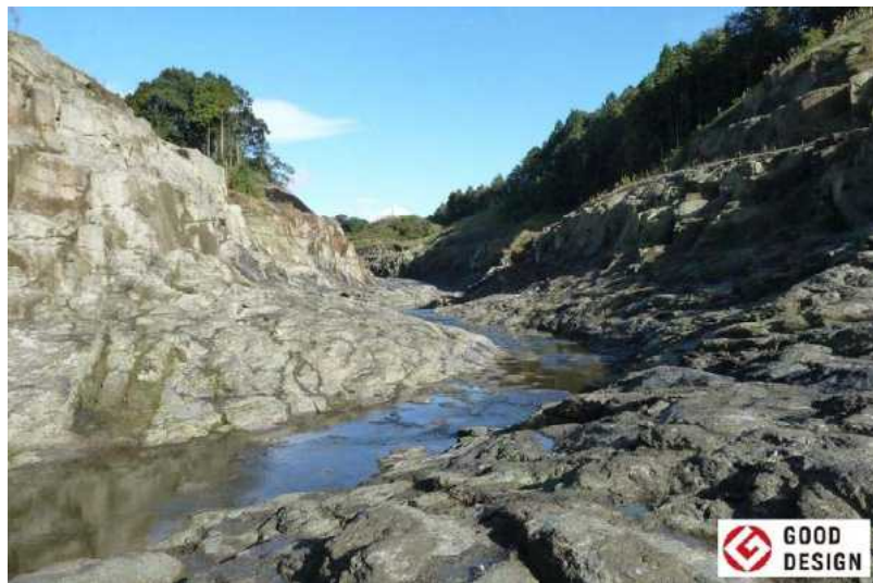
＜川内川曾木の滝分水路の整備＞
