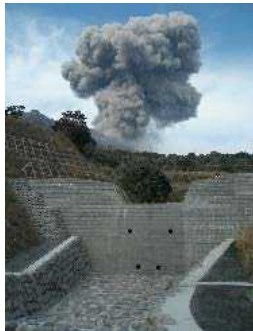
＜砂防堰堤の整備＞
