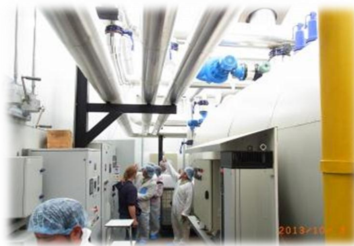
巨大なガスタービンを農場に併設。一台で電気(余剰分は売電)、熱、Co2を生成し利用可能。
