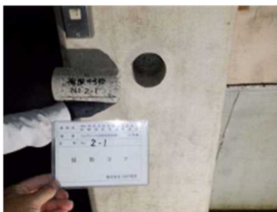
コンクリートコア採取状況
