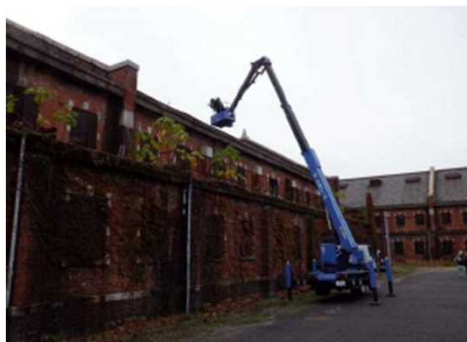
高所作業車による調査状況（北側）
