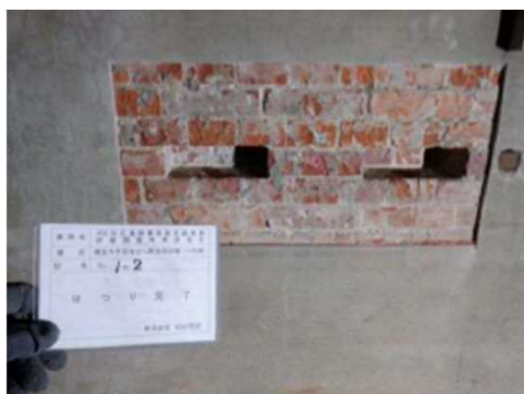
煉瓦壁露出状況
