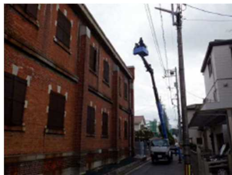
高所作業車による調査状況（南側）
