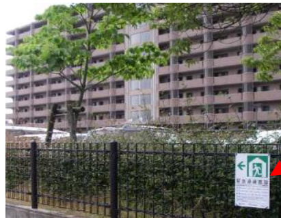
合同宿舎草津住宅（広島市）
