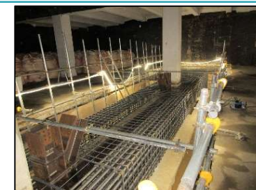
【4号棟1階 配筋状況】
