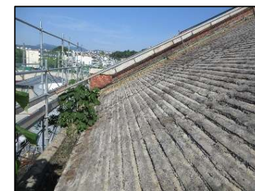
【4号棟 屋根瓦撤去】
