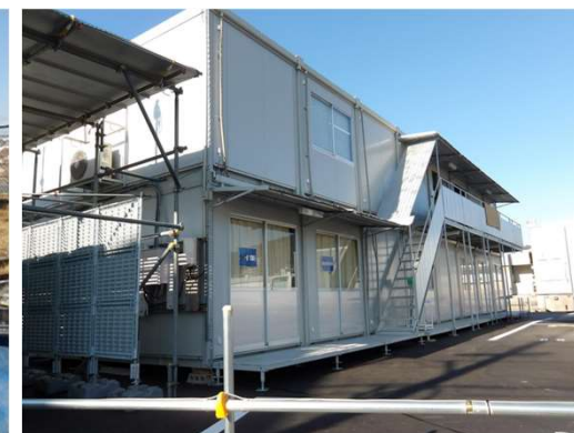
【工事の現場事務所】
