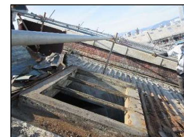
【4号棟 天窓撤去】
