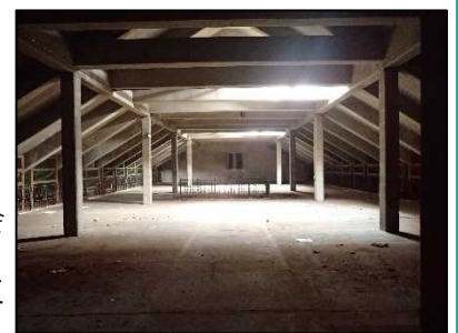
【4号棟の内部の状況】
