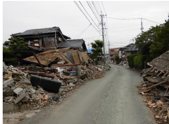
【 益城町の被災状況 】
