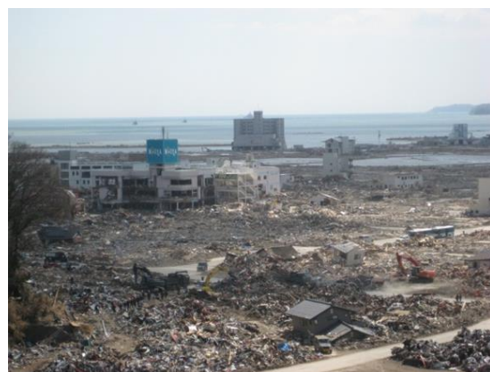
【岩手県陸前高田市旧市役所周辺の被災状況】
